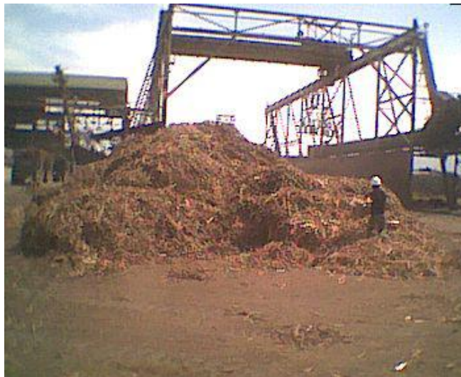
Figura 12. RAC retirado por el sistema de limpieza.
