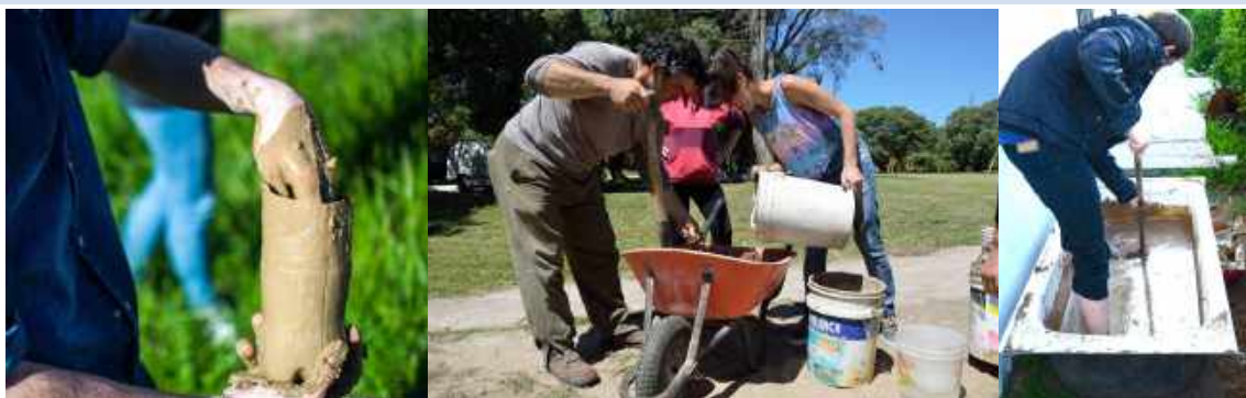
2. Preparación de la mezcla de barro.
