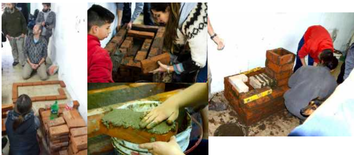
3. Construcción de primera etapa de estufa. Cámara de combustión y torreta
