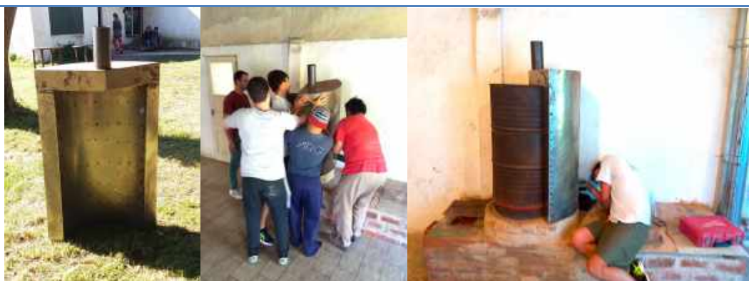
7. Instalacion de intercambiador de calor
