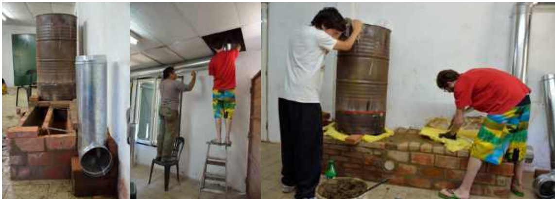
5. Instalación de cañerías y aislamiento
