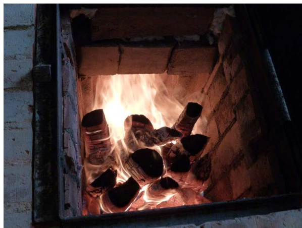
Figura 10: cámara de combustión de “Gymse” con carga horizontal. Se observa el fuerte tiraje hacia la chimenea de combustión interna
