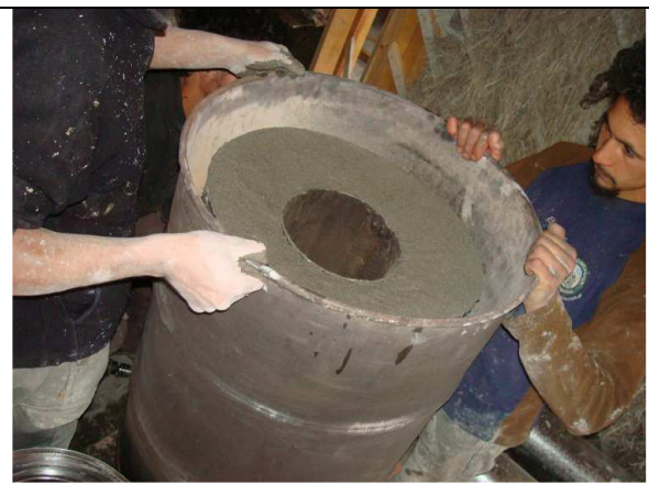
Figura 2b: Chimenea de construcción alternativa con caño de hierro, y tambor exterior de 200 litros para salida de gases.
