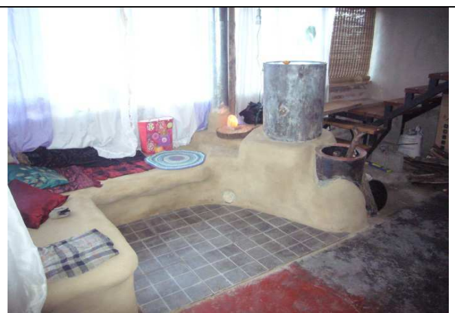
Figura 3b: Estufa rocket terminada. Se observa la carga de leña vertical, el tambor externo a la chimenea interna, el banco másico de intercambio térmico, y la chimenea de salida.
