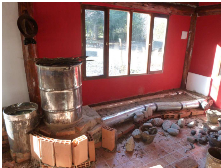
Figura 4: estufa rocket construida con salida de gases en caño galvanizado con uniones selladas.
