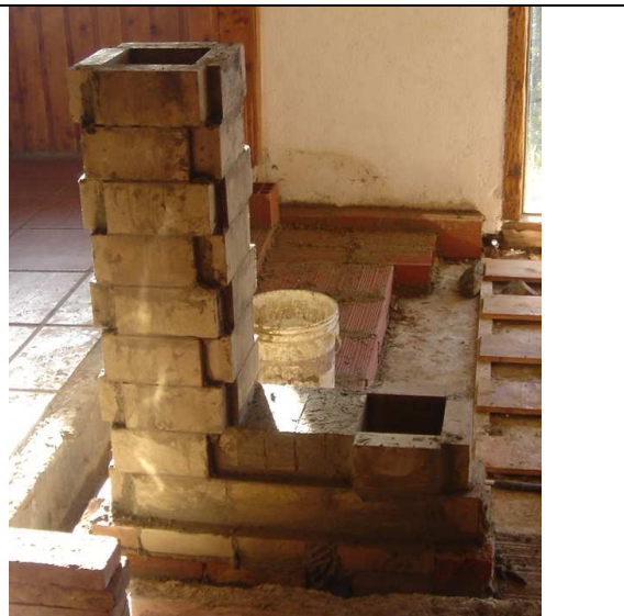
Figura 1b: etapa de combustión de una estufa rocket construida en la capacitación. Se observa la boca de carga de leña y la chimenea de combustión secundaria
