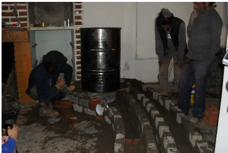
Figura 6: proceso constructivo de conductos de salida de gases en adoquines cementicios
