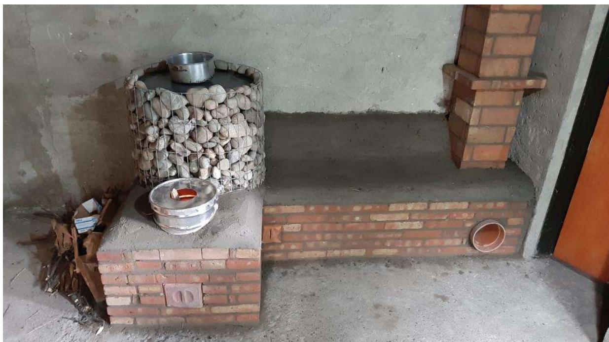
**Figura 5.** Estufa Rocket Jota construida en el marco del proyecto en El Bolsón (Fuente: elaboración propia).
