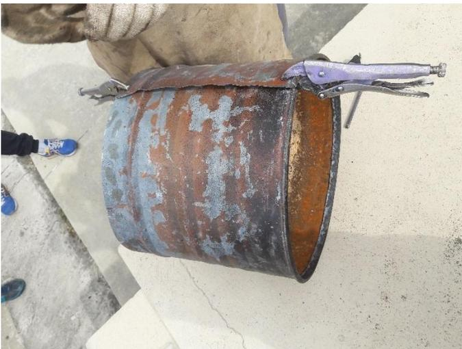
Verificamos los 3 cm de solape, y sujetamos con pinzas de fuerza cada extremo.
