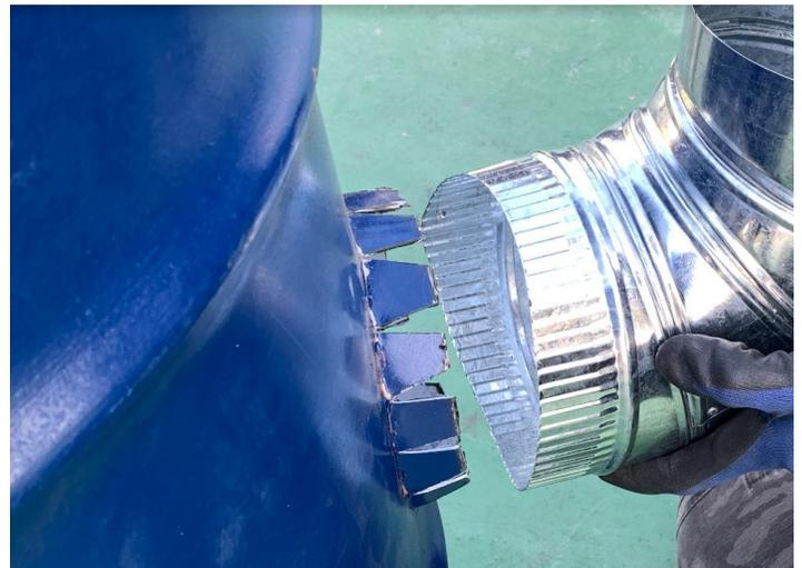
Presentar el codo en el tambor exterior, poner uno o dos tornillos que fijen pero que permitan movimiento, y fijar el caño junto con los soportes que vienen en el kit. En la unión vertical entre el codo y el caño, el caño tiene que ir por su extremo macho y el codo por el extremo hembra (de esta manera los condensados quedan dentro del sistema).
